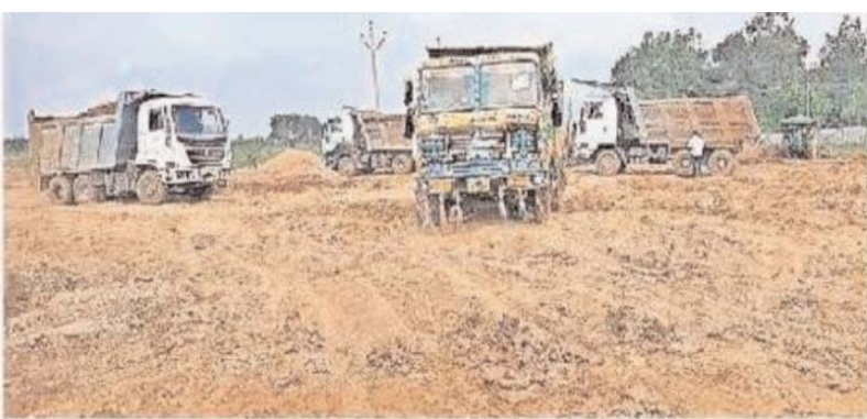
స్కూల్ నిర్మాణానికి జోరుగా సాగుతున్న పనులు
